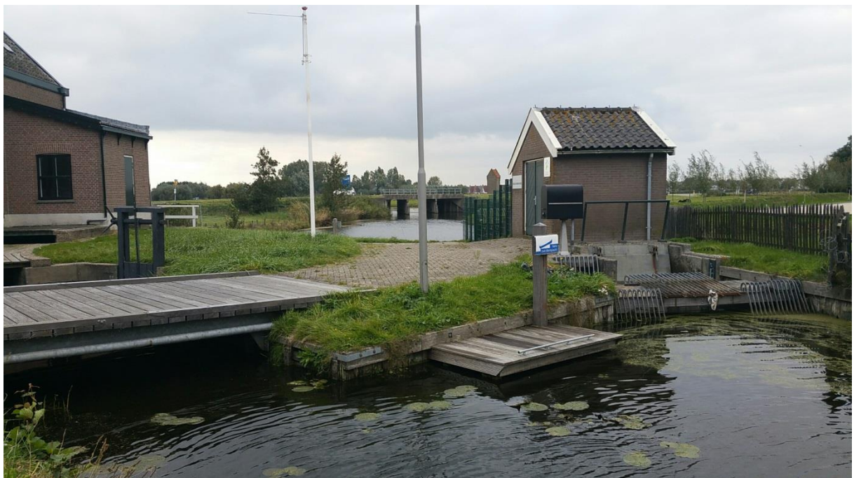
Foto. In- en uitstapsteigers voor kanoërs bij het Gemaal Limmen 1879.
